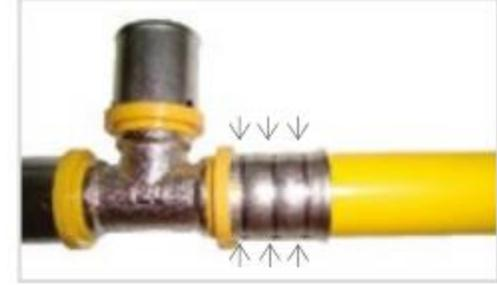
Abra a ferramenta e, no local pressionado, a conexão deverá apresentar o aspecto acima e estar dentro da tolerância de prensagem.
